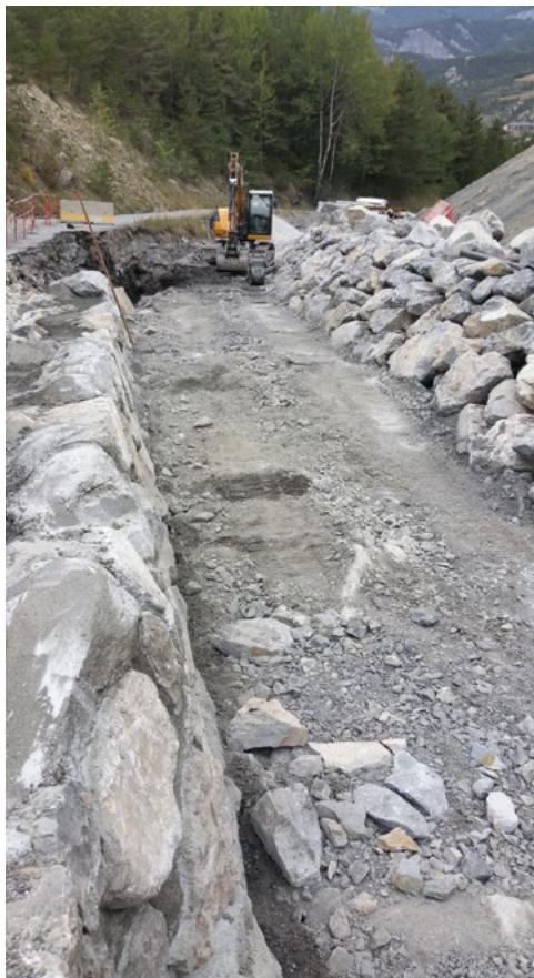
Vue du chantier.
